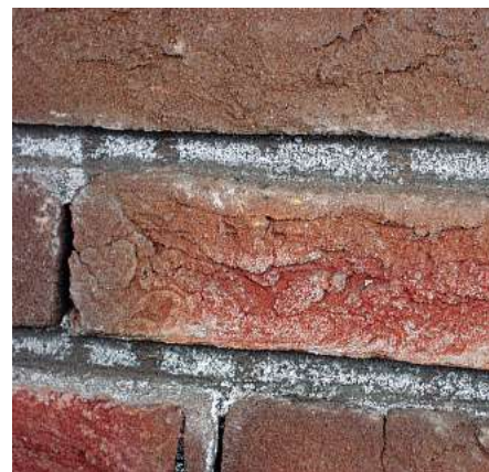
Kalkafzetting in de poriën.
